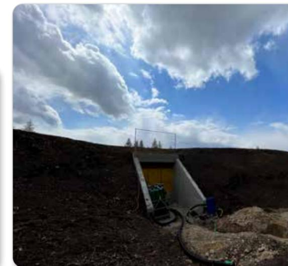
Das Bauwerk wurde in Stahlbetonbauweise ausgeführt, enthält 2 Wasserkammern und eine angebaute Schieberkammer, in der die für den Betrieb erforderlichen Armaturen und Leitungen untergebracht sind.
