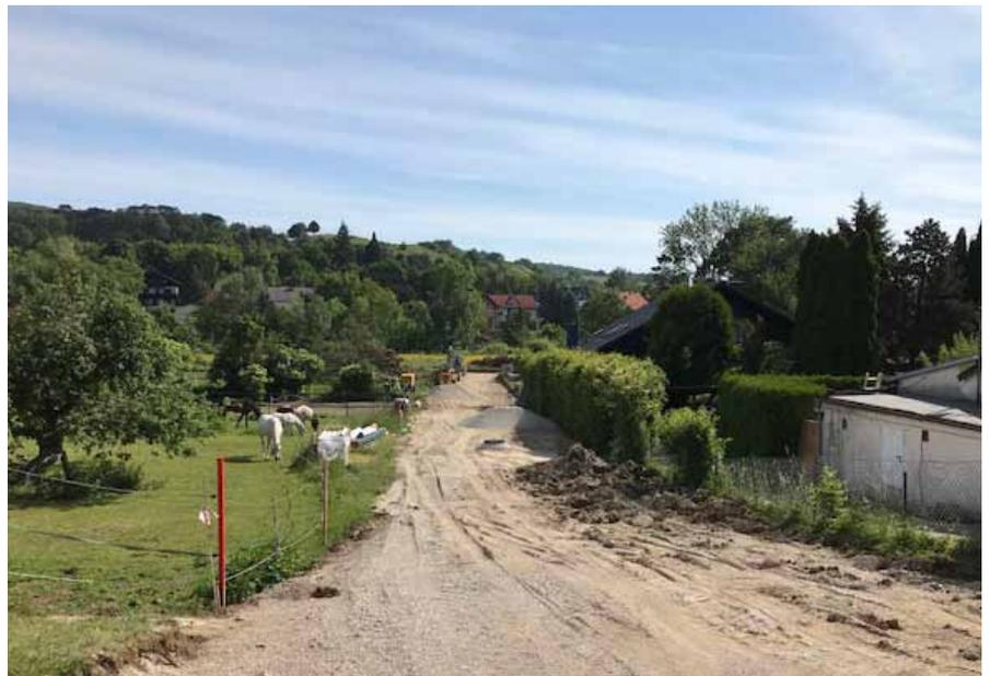
In Sulz wurde auf der Festleiten ebenfalls eine Baustraße angelegt. Die Einbauten wie Regenwasser und Fäkalkanal folgen. Für die Wasserversorgung ist der Triestingtaler Wasserleitungsverband zuständig.
